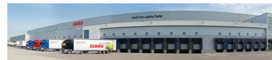
Het CLAAS Parts Logistics Center in Hamm, Duitsland, beschikt over 200.000 verschillende onderdelen op een bedrijfsterrein van meer dan 140.000 m².
